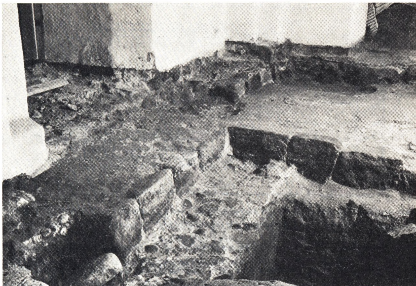
Fig. 3. Udgravning i Blistrup kirke, Holbo herred. Billedet viser skibets sydvesthjørne, set fra nordøst. Det ses, hvorledes trinnet foran syddøren (øverst t.v.) fortsætter i en forhøjning i skibets vestende. I hjørnet er der rester af den murede vægbænk, og det ses, at den gotiske hvælvingspille er anbragt direkte på bænkens overside. Hullet nederst t.h. er fremkommet ved udgravning i en grav. Forf. fot. 1966.
