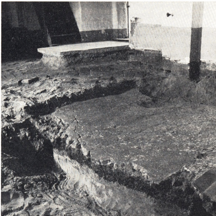
Fig. 1. Gulvlag i Stenløse kirke, Ølstykke herred. Det romanske mørtelgulv er i forgrunden afbrudt af begravelser i skibets midtgang. Billedet giver et indtryk af de stadige hævnninger i kirkens gulvniveau. Hans Stiesdal fot. 1956.
