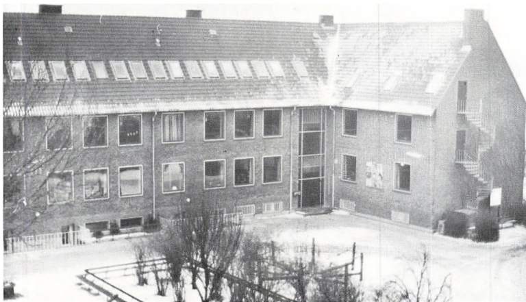
Fig.77. »1957-bygningen«. Fot. januar 1987.
