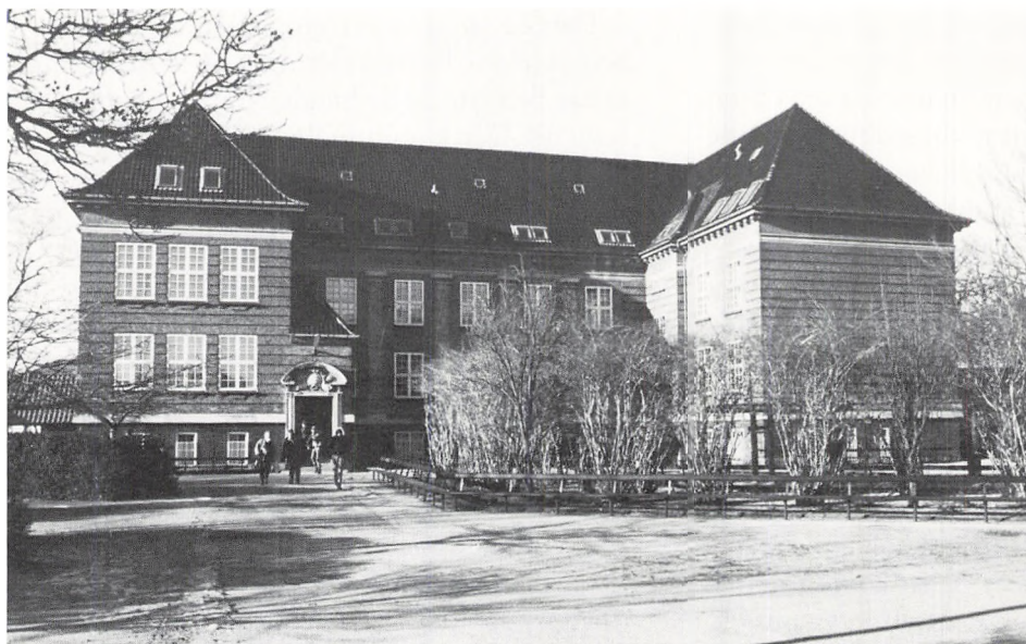
Fig. 72. »1921-bygningen«. Fot. januar 1987.
