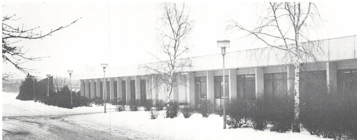
Fig. 79. »1973-bygningen«. Fot. januar 1987.
