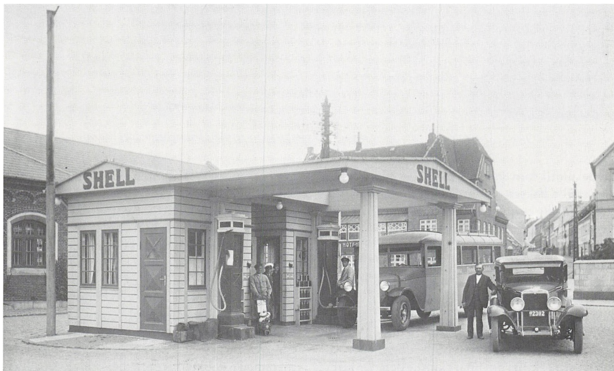
Fig.39. Shell stationen på havnepladsen i Rudkøbing, fotograferet i 1930-erne. Rutebilen Rudkøbing-Tranekær-Lohals holder ved benzinstanderen.
