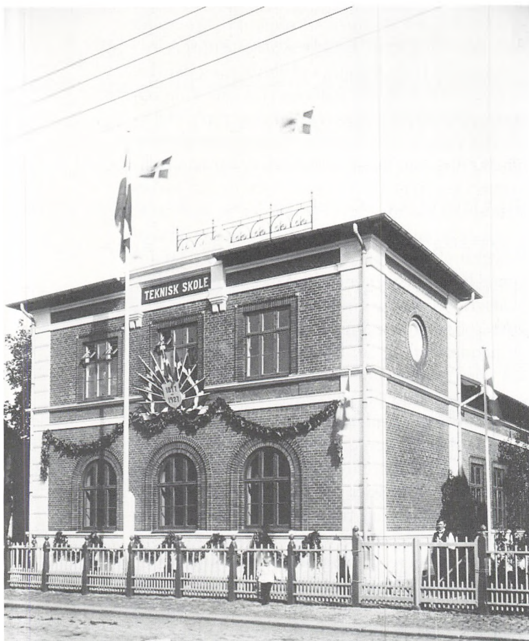
Fig.80. Teknisk Skole, Ahlefeldtsgade 28. Fot. 1927.
