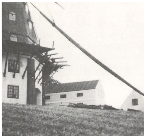
En ny møllearm er ved at blive rejst i 1942. Når man ser manden til højre, forstår man møllevingens størrelse. (S.A.)
