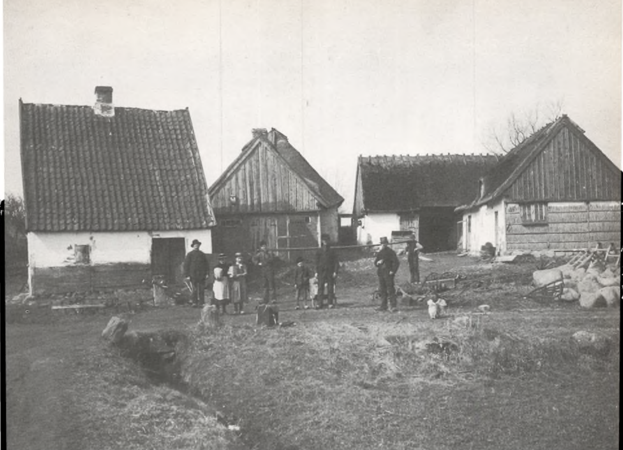
Stenløse smedie ca. 1890. Smedehuset var som et af de få huse i byen tegltækket, for at taget ikke skulle antændes af gløder fra essen. (S.A.)
