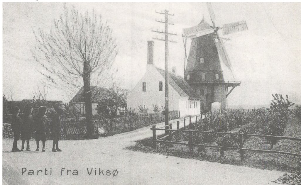
Veksø Mølle med have og landbrug set mod syd ca. 1910. Taget ved bageriskorstenen var af tegl, så ikke gnister fra ophedningen af ovnen skulle antænde stråtaget. (S.A.)
