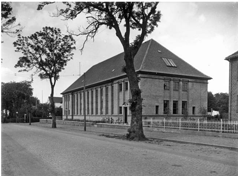
På Haderslevvej, tidligere Nørre Chaussé, i Aabenraa ligger Landsarkivet, hvor Carsten Petersen som pastor emeritus fik sin daglige gang fra 1932 til sin død, resulterende i en del historiske afhandlinger og det store samleværk Slesvigske Præster, baseret på et kvalificeret arbejde med vanskeligt tilgængelige kilder. Foto: Museum Sønderjylland – ISL.
