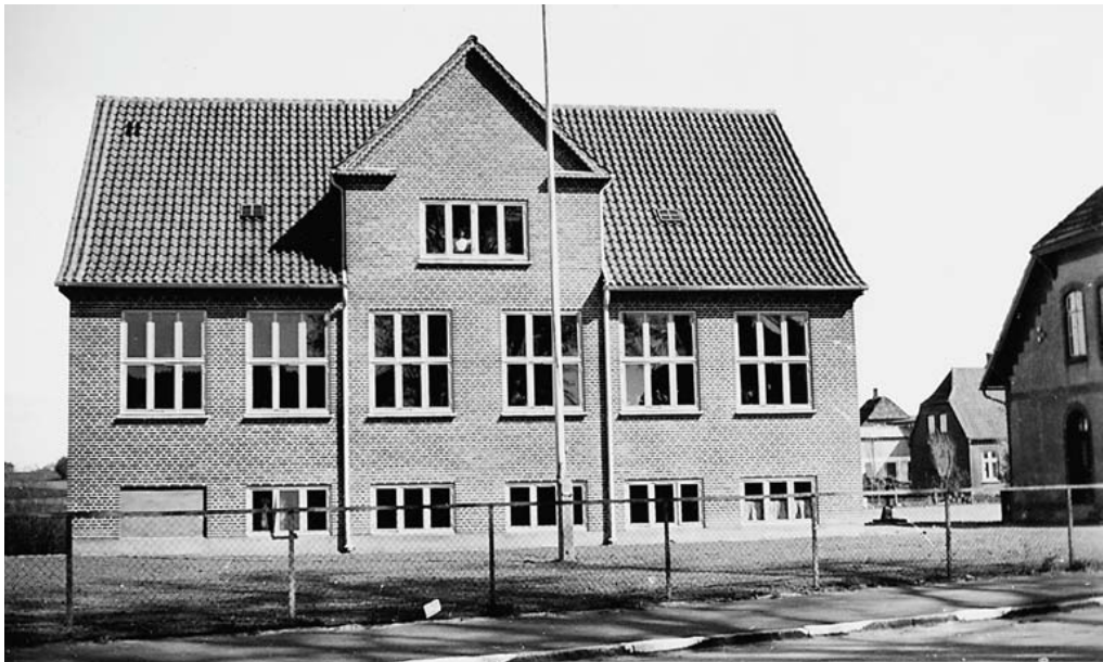
Den toklassede Adsbøl Skole i Aabenraa Amt havde i 1940 fået egen gymnastiksal, sløjdløkkale og skolekøkken, men de sanitære forhold i lærerboligerne var så ringe, at førstelæreren ønskede en anden stilling. Lærerinden fik først ordentlige boligforhold, da hun i 1962 fik anvist indkvartering i en nyopført andelsbolig i Gråsten by. Foto af skolen: Museum Sønderjylland – ISL.
