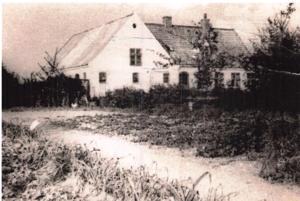
Foto ca. 1955. Der er kommet sprosset gavlvindue, hvilket tyder på, at der er indrettet bolig, evt. bare et enkelt gavlværelse på første sal. Til højre for gavlen ses en havedør med buet stik og udseende som den nordvendte hoveddør. Ejer var Erik Colding Jensen fra 1952 til 1959.
