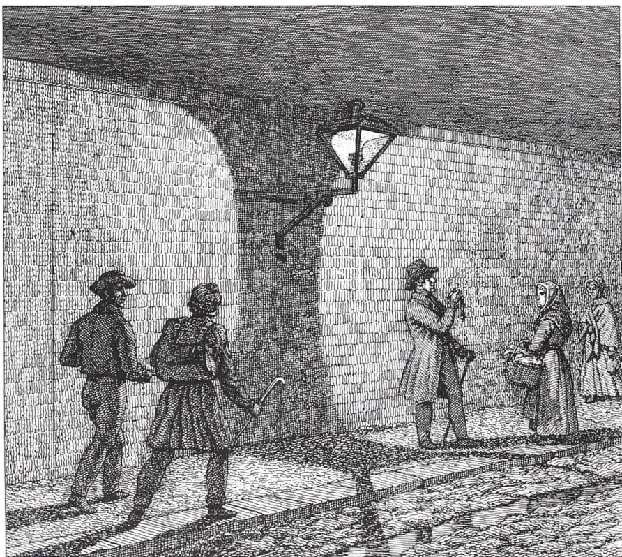
Nattebilleder, der viser gadelygter i funktion, er yderst sjældne. Men C. W. Eckersbergs radering af den lysende lygte på en mur hører til undtagelserne. Grænsen mellem lys og skygge på muren viser, at lygten er forsynet med en »reverbator« – et hulspejl, der reflekterer lyset og kaster det udefter. Den kongelige Kobberstiksamling.
