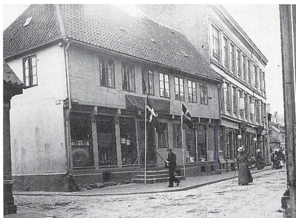
Fig. 9. Udsigt mod gavlen med forhusets murede gavl, ca. 1900-1905. Fotograf sign. Benzen, i Købstadmu-seet »Den gamle By«.
