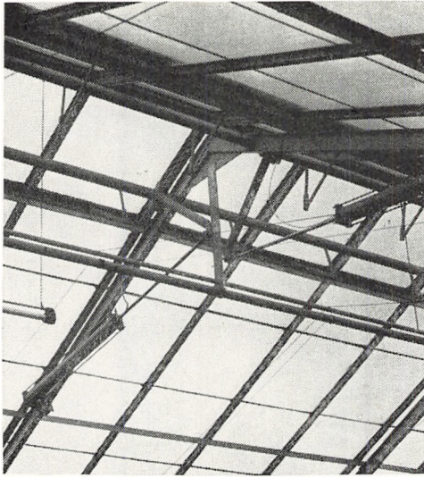
Vinduesopluk ved trykluft.
