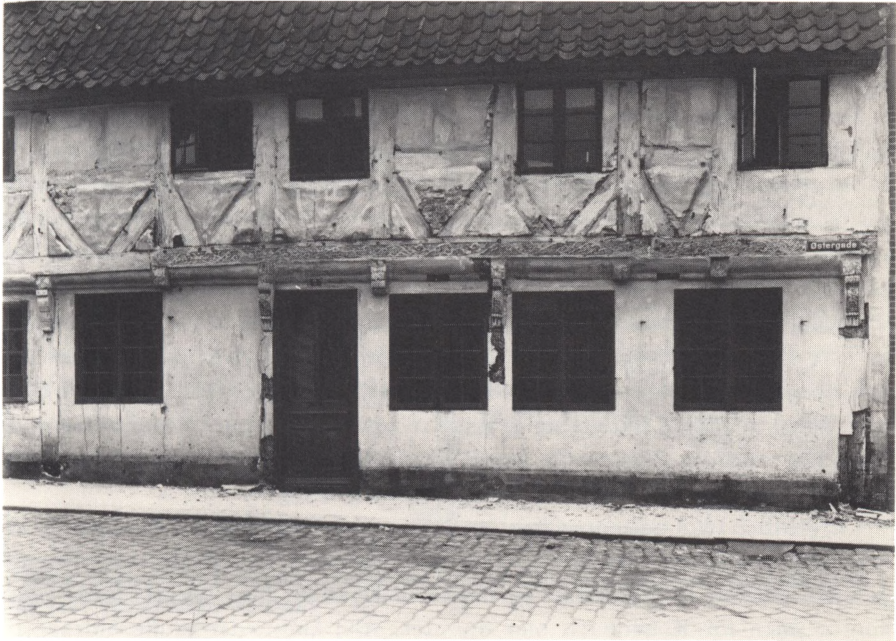
Landbohjemmet (Erik Menveds Kro), Østergade 2 er en af byens ældste eksisterende bygninger. Bygningen synes opført i 2 omgange, idet den nordlige del er ældst og fra ca. 1600. Billedet her er taget under husets restaurering i 1934. (Foto: Nordfyns Museum.)
