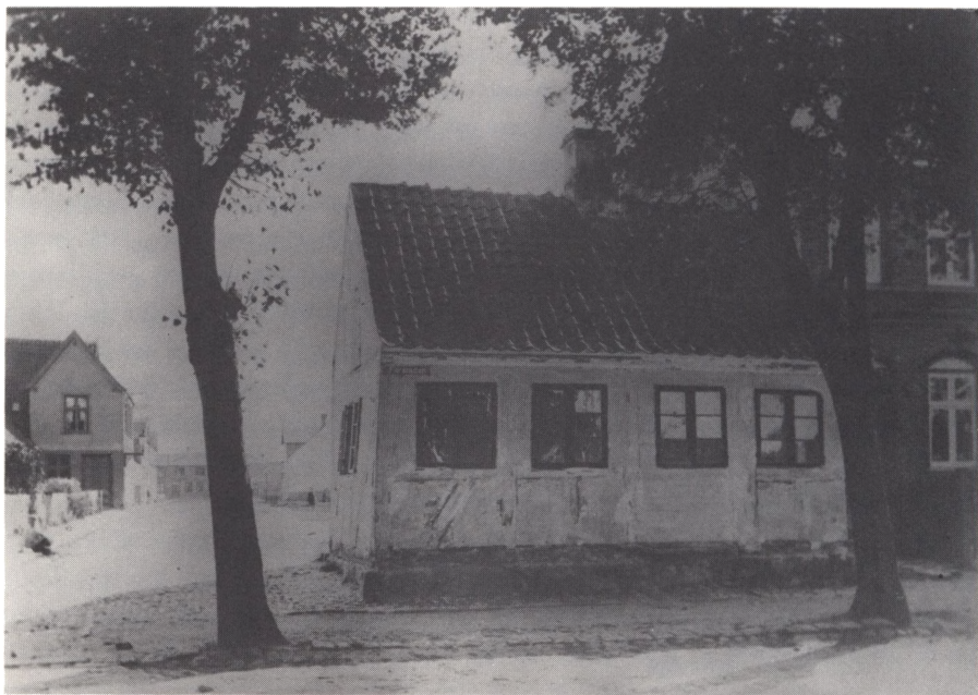
Her ved Gl. Toldbodvejs udmunding i Odensevej opkrævedes afgifterne af de forskellige varer, som førtes til byen. (Foto: Nordfyns Museum.)
