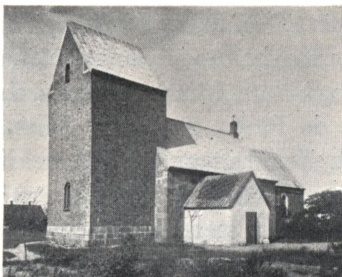
Vildbjerg Kirke før Ombygningen.
