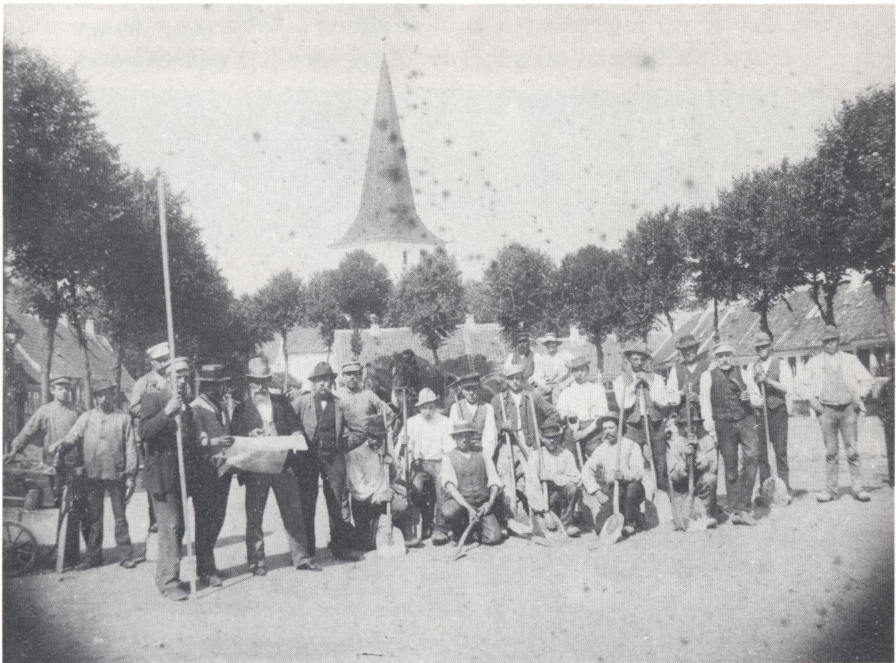
Bogense Gasværk anlagdes i sommeren 1896. På billedet er arbejdsstyrken fotograferet på Torvet. Rørlægning og installationsarbejde var overdraget firmaet Schultz & Ejby i Fredericia, og det ledes af konduktør Sørensen, der ses til venstre pegende på kortet.
