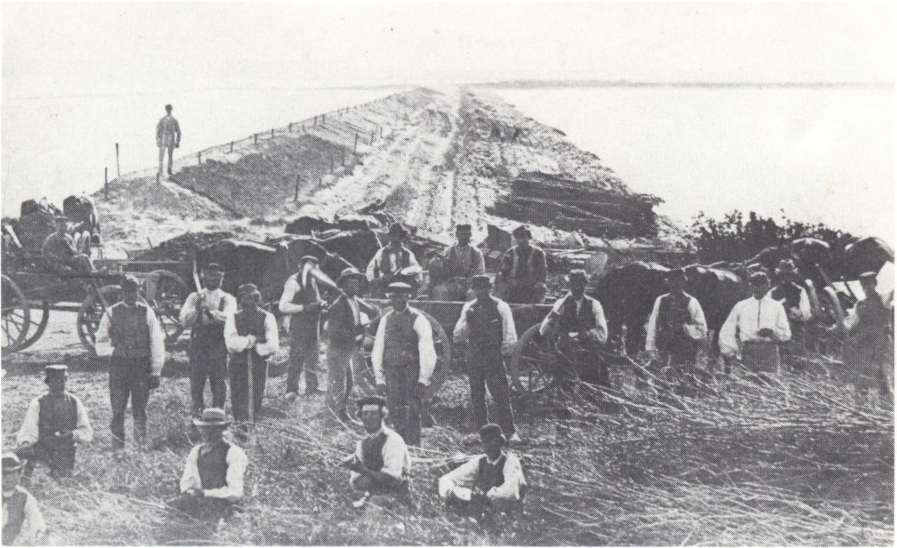
Inddæmningsarbejde ved Langø i 1870'erne. Inddæmningen blev foretaget af Gyldensteen, og der inddæmmedes ialt 1100 tdr. land.
