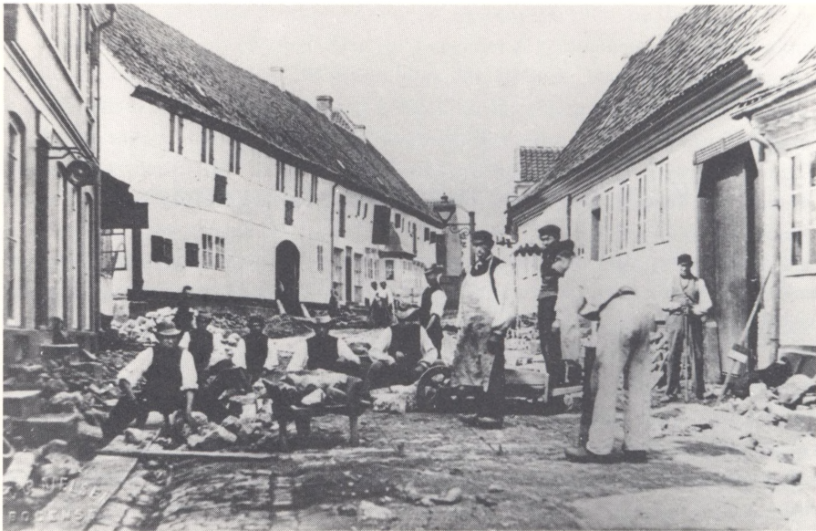
Byens brolægning var i ringe stand, og det blev der rådet bod på i 1870'erne, hvor byen optog lån på 40.000 kr. Adelgade fik ny brolægning i 1874, Østergade, som ses på billedet, året efter. Den første gade, der blev belagt med tjære, var Teglgårdsvej, og det skete først i 1930.
