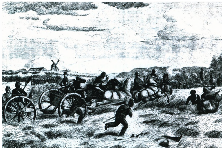
Nybøl den 28. maj 1848. For at sikre Als og forbindelsen til Sundeved, samt for at forstyrre de tyske planer, angreb den danske hær den 28. maj de tyske styrker, der overvågede Als. Under angrebet måtte Batteriet Jessen på åben mark tage kampen op mod 16 tyske kanoner, der stod i en dækket stilling ved Nybøl Mølle. Det danske batteri blev slemt medtaget, men blev reddet af Batteriet Bruun, der galoperede frem, gik i stilling og begyndte at beskyde fjenden ind fra flanken.
