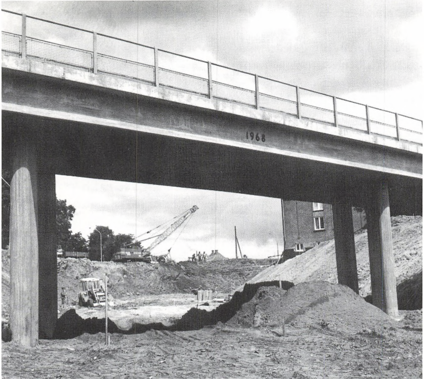
Hvor Ahlefeldvej krydsede jernbanen, blev der bygget en viadukt, og fik navneforandring til Sildekulevej.
