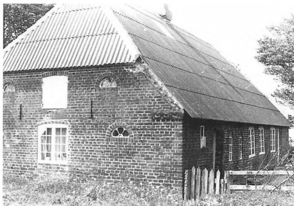
Fotografi af Johannes Johannsens lille hus i Randerup, set fra nordøst. Billedet er optaget i 1966, efter at Nielsine Beyer havde fået lagt bølgeeternit-tag på huset.
