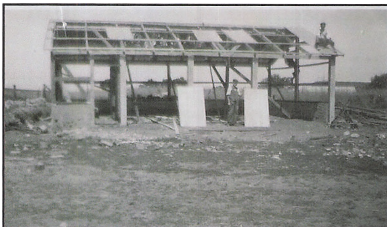
Den nye lade bygget omkring 1932. Min bror Anders ses på taget
