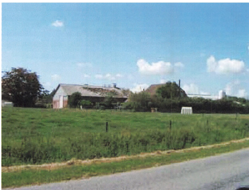
Kløjengvej 19 fra sydsiden
