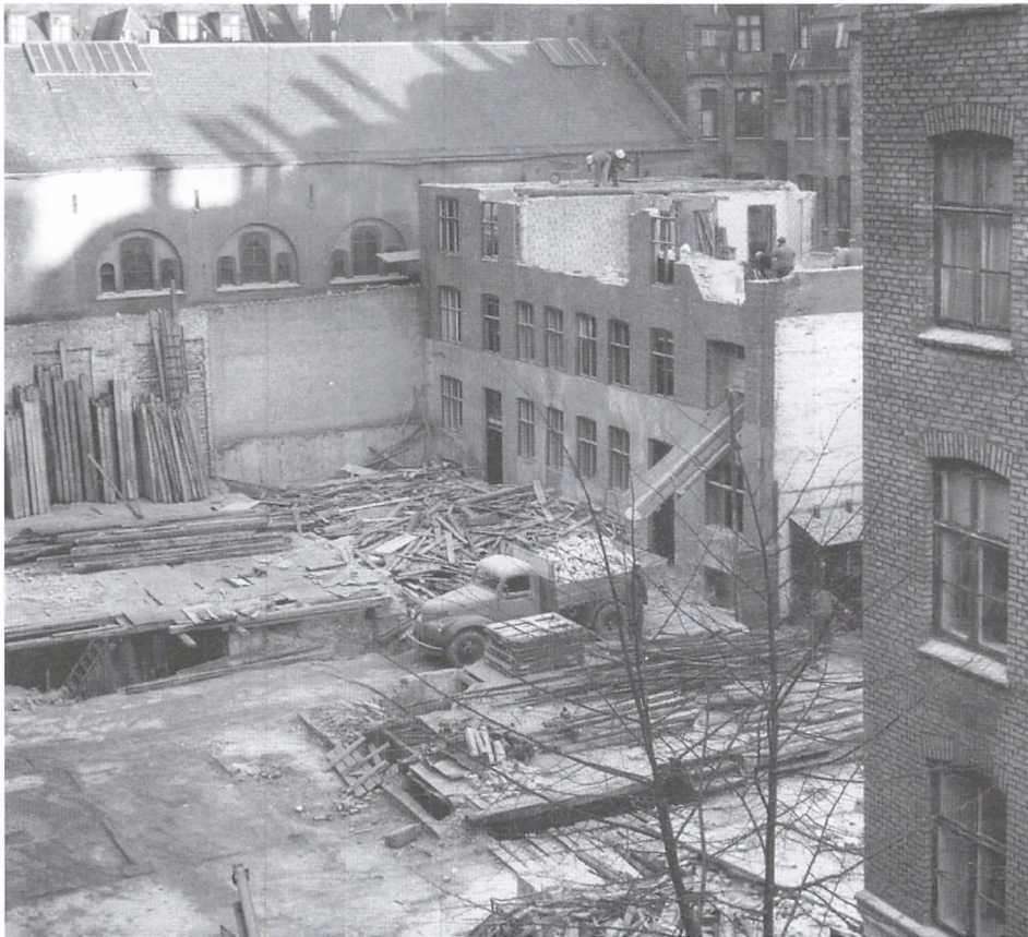
Nedrivningen af baghuset er i fuld gang, mens mellembuset allerede er jævnet med jorden. Det er Apostelkirken, der ses i baggrunden. Billedet er fra 1958.
