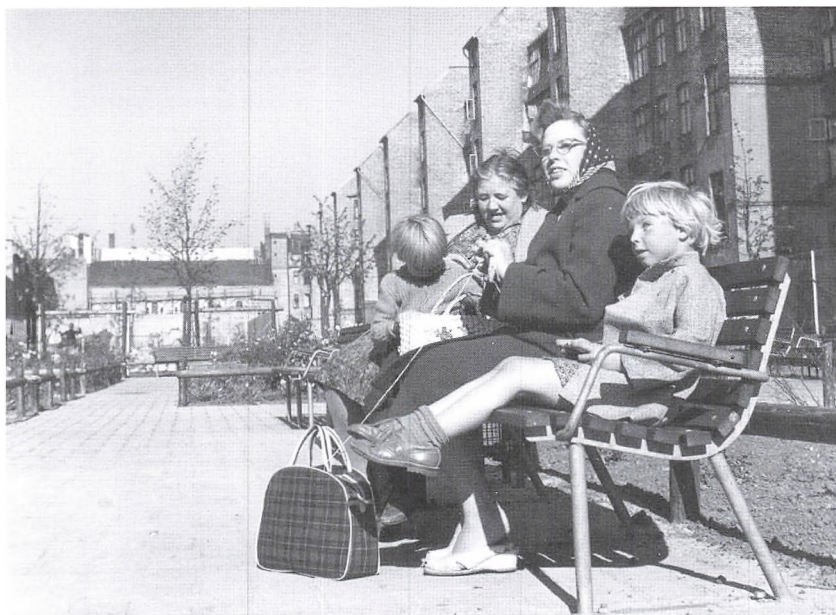
De skumle baghuse er blevet erstattet af et rekreativt gårdmiljø. Det er Apostelkirkens bygning, der anes bag muren i baggrunden. Billedet er fra 1961.
