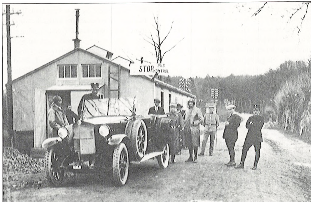
Paskontrollen i Kruså havde - efter den endelige grænsedragning - til huse i en barak over for »Kroen« indtil dennes ombygning var tilendebragt o. 1922.
