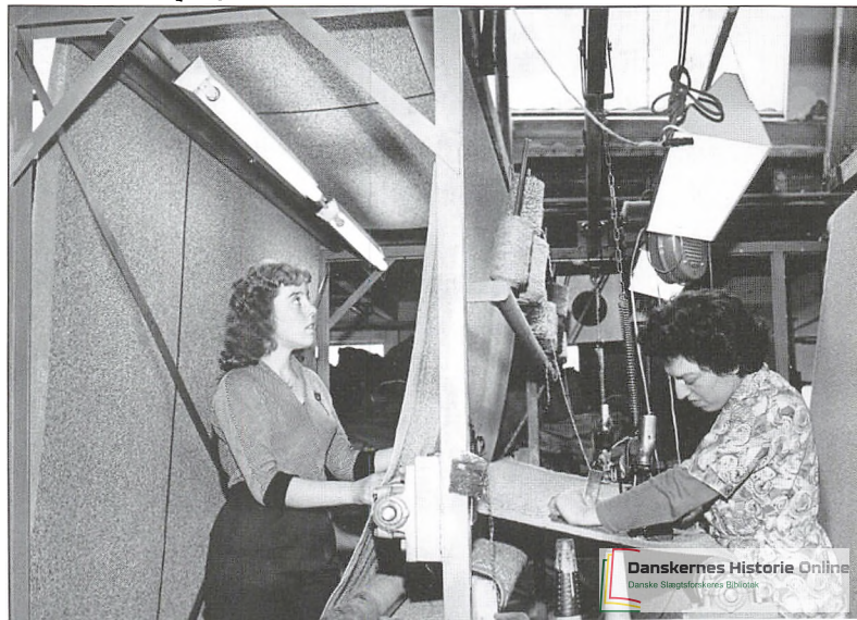
Interiør, etape 3, november 1960
