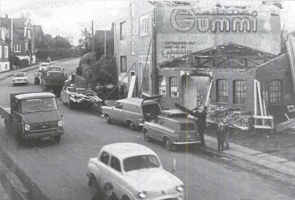
Nordbyvej 6, under ned- brydning
