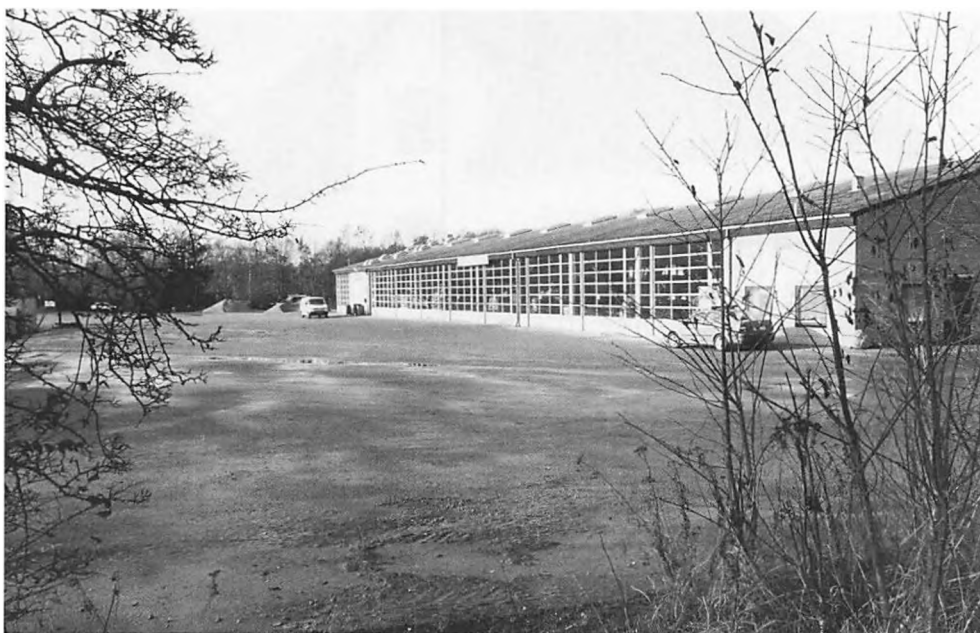
Den nye brandstation. Fotografi. 1997.
