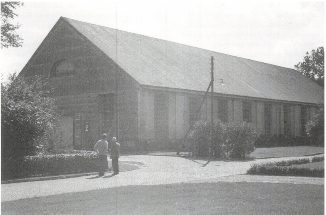
Den af flygtningene mindst elskede bygning i lejren - „Ridehallen“. Hallen, der bl.a. anvendtes til indkvartering, var lejrens største bygning og næsten umulig at opvarme i vintermånederne
