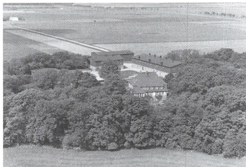
Røj under Schackenborg fremstår i sin helhed i byggestilen som et typisk eksempel på en tysk domænegård. De solide og rummelige avlsbygninger med høj trempel er fra 1916. Byggesummen var 80.000 mark.
