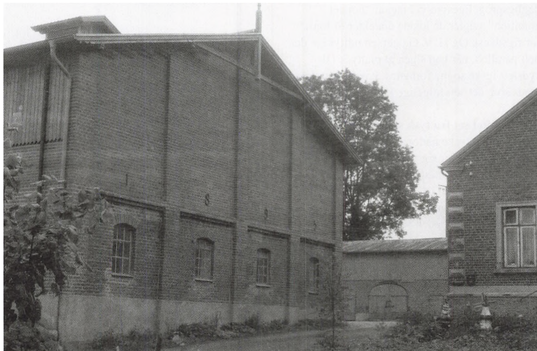
Unewatt: Trempellade fra 1895. De enorme trempeller i de syd- og østslesvigske gårde (inkl. Als og Sundeved) skyldtes ud over større høstudbytte også, at man efter nordtysk-holstensk model gik over til at lagre afgrøderne på lofterne inden tærskning. Foto: Peter Dragsbo 2000.
