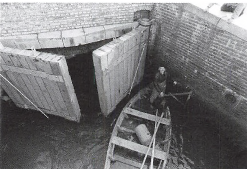
I 1993 blev sluseportene udskiftet. Hver af de nye porte er 4,50 m i bredden og 4,30 m i højden og udført i Azorbe, en meget hård afrikansk træsort. Alle beslag er i rustfri stål. (foto:Lis Sylvest)
