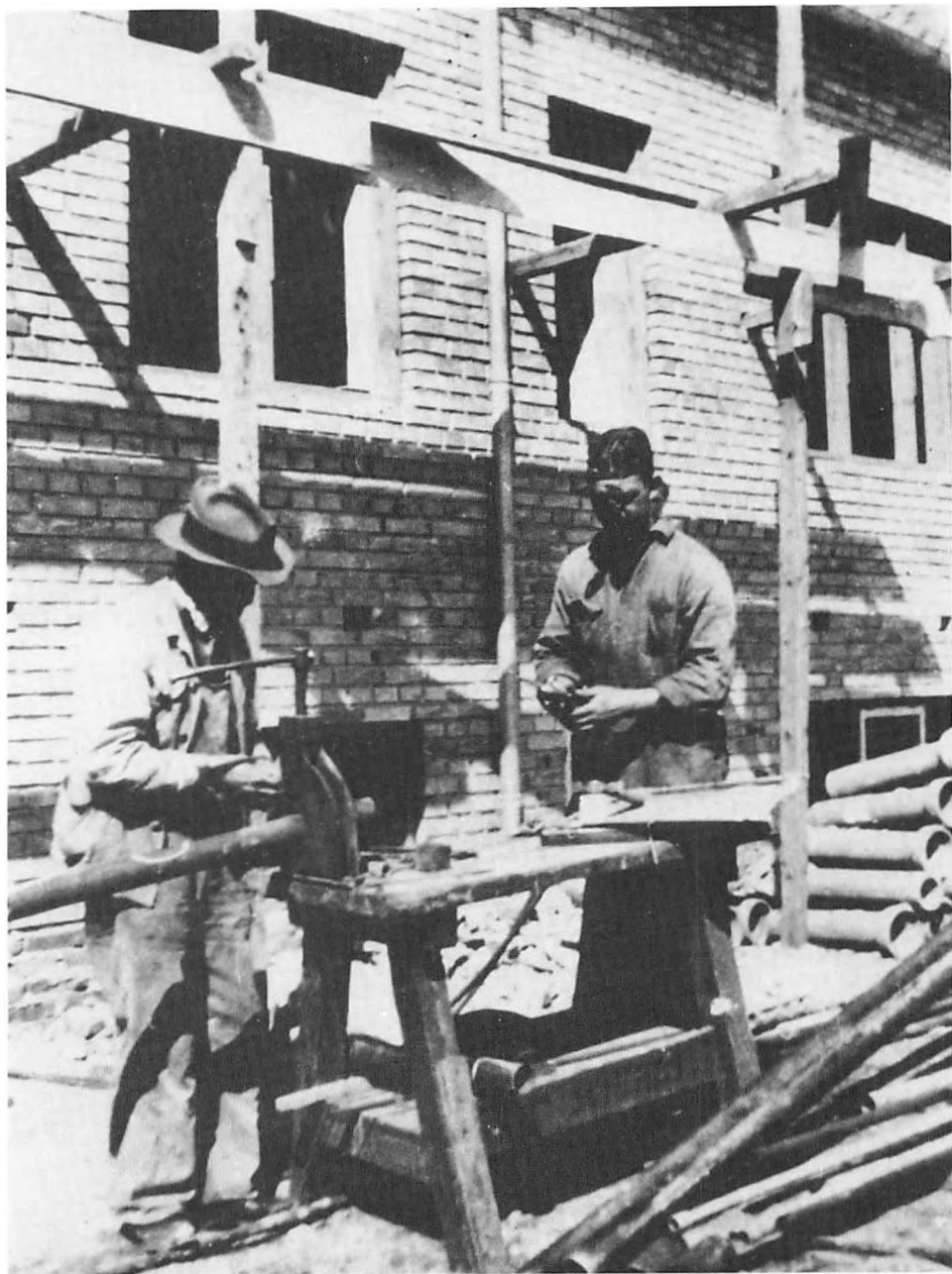
Rørlæggere ved rørbænk under arbejdet med at indlægge centralvarme i karré på Tørholmsvej i 1942.
