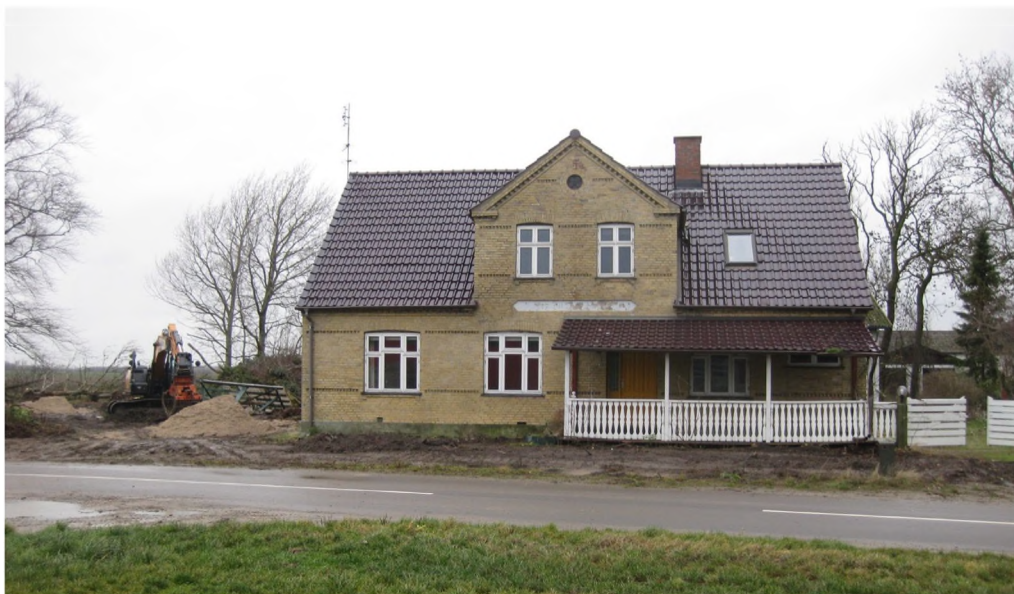
Den forhenværende slagterbolig rives ned. Først fjernes buske og træer omkring bygningerne, herunder den hundredårige blodbøg. Så fjernes bygningerne. Privat foto.
