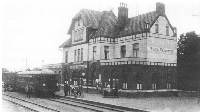
Banegården i Burg opført 1905 i nationalromantik med en solid bund af ren mur i stueetagen og pudsede vægge på første sal. Fra 1995 til 2015 har bygningen været anvendt som restaurant.
