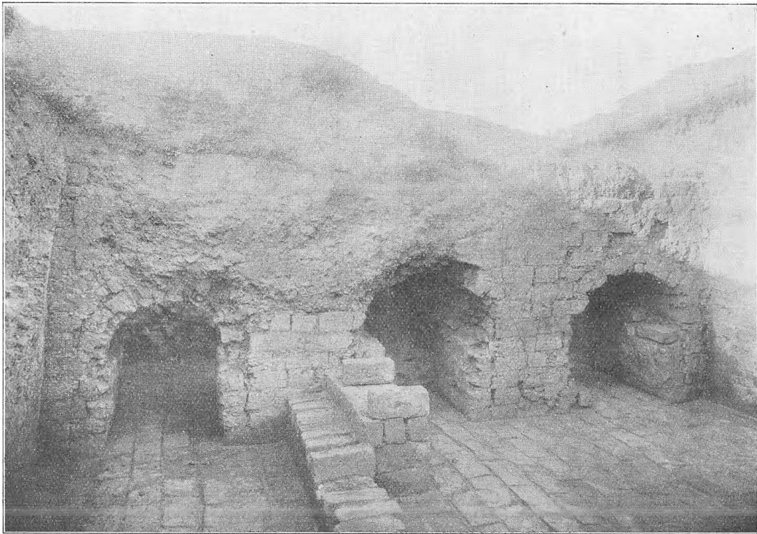
Nordmuren med Fyrhuller.
