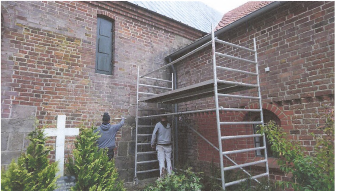
Hjørnet mellem kirkeskib og søndre korsarm fuges. Privatfoto.
