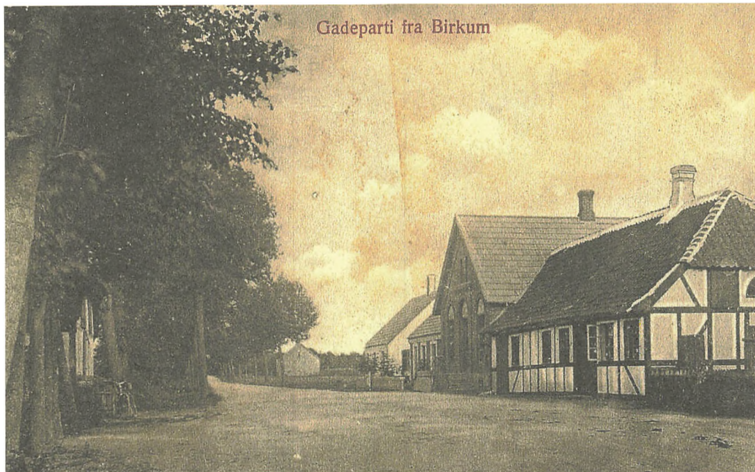
Bindingsværkshuset er den første brugs i Birkum fra 1899, bagved med de store butiksvinduer ud mod gaden ses den nye brugs fra 1901. Foto: Lokalhistorisk Arkiv for Fraugde og omegn.
