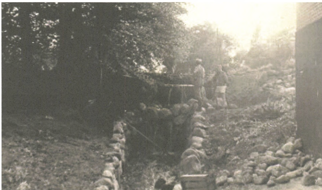
Opbygning af stensætning hvor vandhjulet skulle stå. Thorkild Frandsen og til højre nabosønnen fra Damsbo. Foto: Frede Frandsen.
