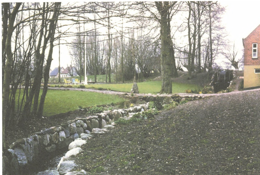
Færdigbygget stensætning hele vejen igennem haven op til vandhjulet. Foto: Frede Frandsen.
