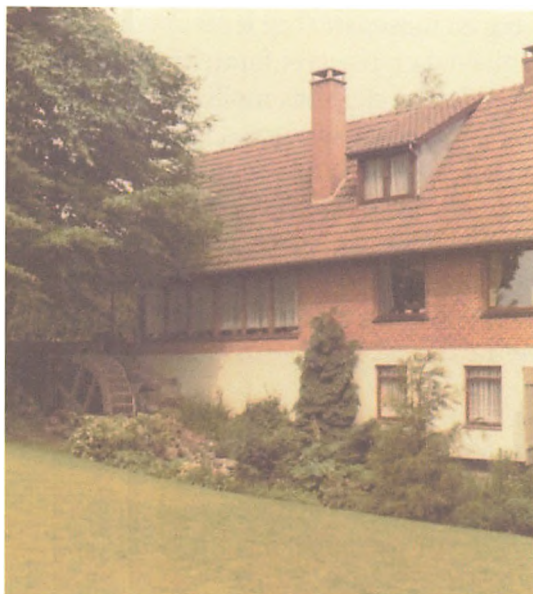
Bellingehuset årgang 1916. Foto: Frede Frandsen.
