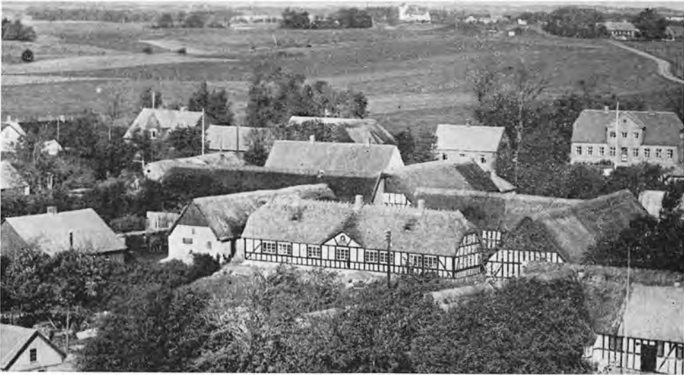
Matr. 5a m. fl. Restaureret 1950.
