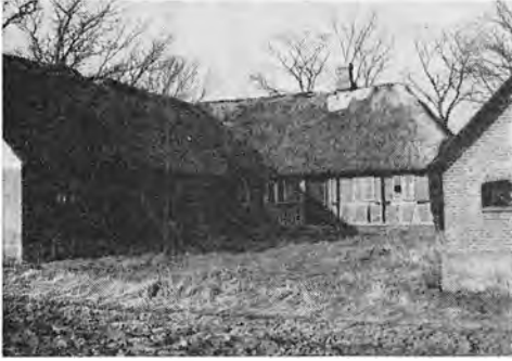
Matr. 5e m. fl. Bygningerne er faldefærdige. Billedet fra 1970.
