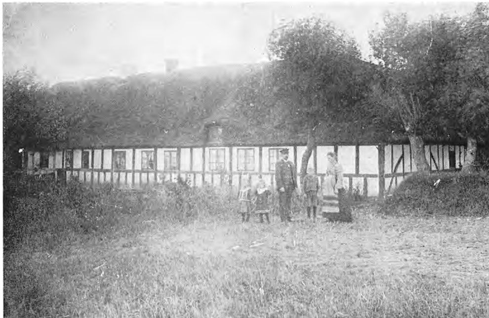
Matr. 12e Lillevirring. Bygningerne ca. 1900.
