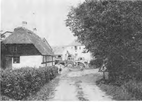
Kloakering i Fruering. 1970. Huset til venstre har oprindelig tilhørt Ejendommen Sandet, nu Solhøj.
