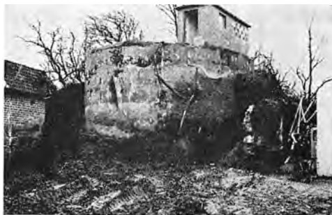
I 1972 er der bygget nye Vandværk i Virring, og det gamle nedrives.
