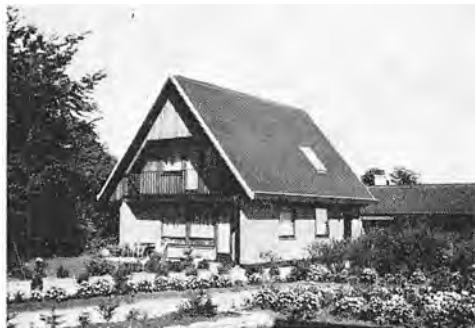
Matr. 11d. Huset, som det ser ud i Dag efter en omfattende Modernisering.
