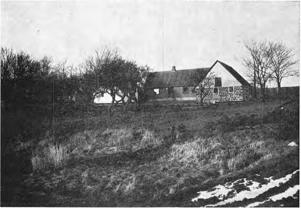
Matr. 11b Virring Hede. Nedlagt som Landbrugsejendom. Der er bygget til Stuehuset i 1976.
