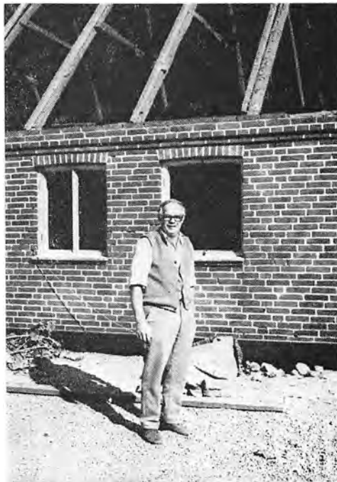
Galvanisør Anders Møller bygger nyt Stuehus paa Gammelgaard 1972. Han købte Bygningerne efter at Jorden var frasolgt og indrettede dem til Galvanisering af Metaller. Der er senere sket store Udvidelser, og der er efterhaanden opstaaet en stor Virksomhed paa Stedet.
