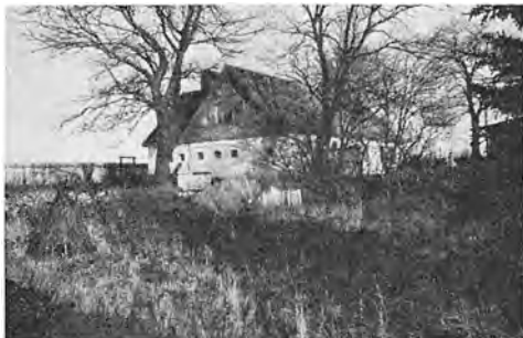
Arkitektens Hus som det ser ud i 1970.
