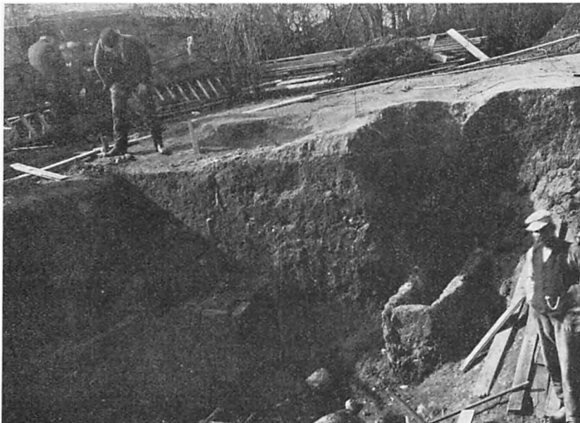
Udgravningen af Sct. Mikkels Kirke ved Lille Graabrødrestreæde.
