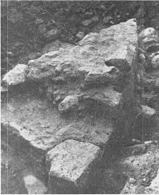
Fra Alle Helgens Kirke. Et Stykke af Rundkirkens tykke Fraadstens-Mur. Den er bevaret i flere Skifters Højde; øverst oppe ses en Stump af Skraakant-Sokkelen, forrest den lige Afskæring til Indgangen og Anslaget til Døren.
