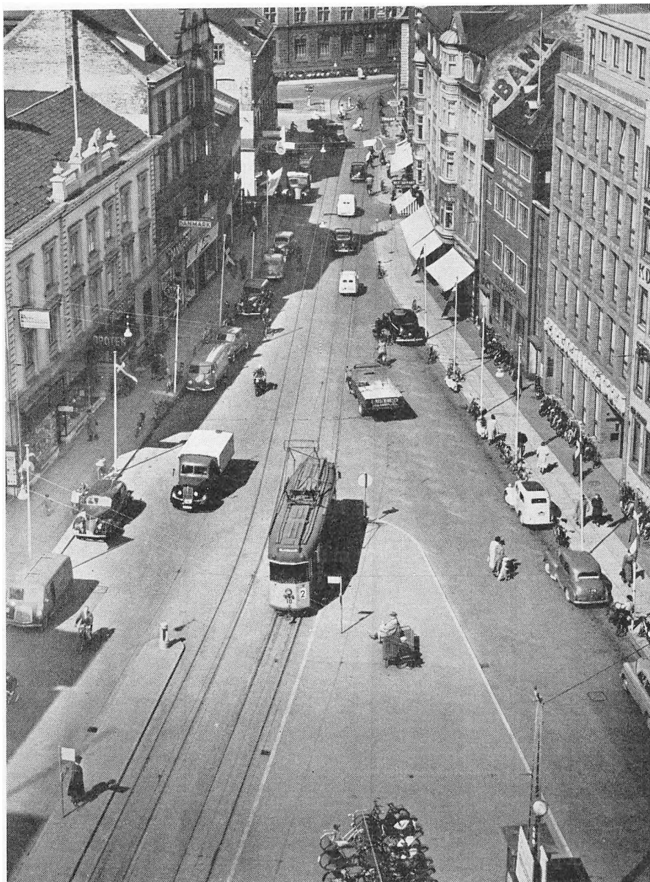
33. Store torv—Borgporten. Den tilspidsede facon og det snævre „pas” mod Lille torv giver særlige arkitektoniske muligheder.
