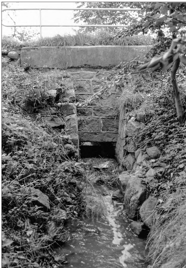
Edelgave Bro. Stenkistebroens facade og støttemure i vest fotograferet i 1992, hvor bygværkets omhyggeligt tildannede stenkvadre og optrukne furer stadigvæk var synlige. Kun en reparation med cement af broens øverste (knækkede?) dæksten skiller sig ud. Brofacaden er i dag jorddækket. Foto: Jens Henrik Jønsson.
