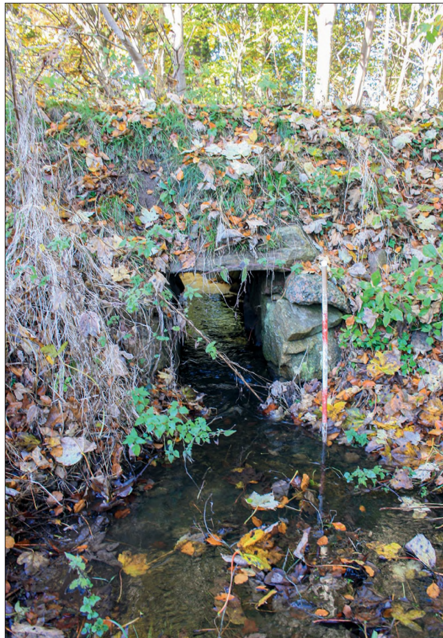
Vejstenkiste der tidligere har ført en markvej fra Edelgaves gårdsplads over Grønsø Å. Stenkisten har i sit gennemløb tidligere været noget længere og forsynet med et lukke af jern, hvorved åens vand kunne opstemmes i en lille dam. Foto: Jens Henrik Jønsson.
