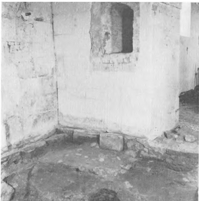
Fig. 4. Nordre sidealter-fundament. Bemærk lergulvet foran fundamentet og den lodretstillede kvader under nichen.
