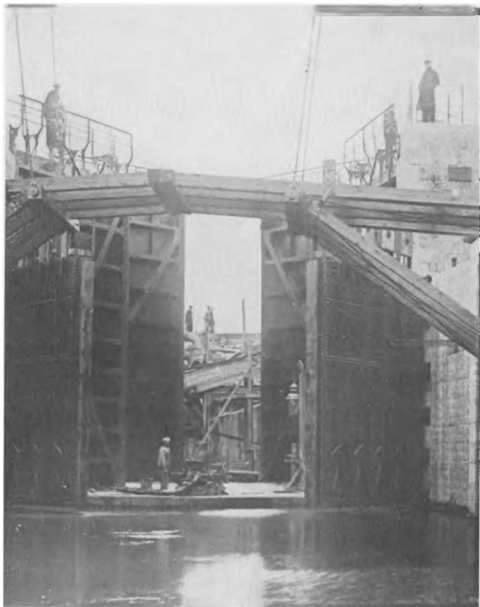
Fig. 11. Ribe kammer-sluse under bygning. Man ser fra slusens næsten tørlagte bund imod vest ud imod skylleporte og stormporte. I forgrunden foroven ses den nu afmonterede klapbro under bygning. (Hedeselskabets arkiv).
