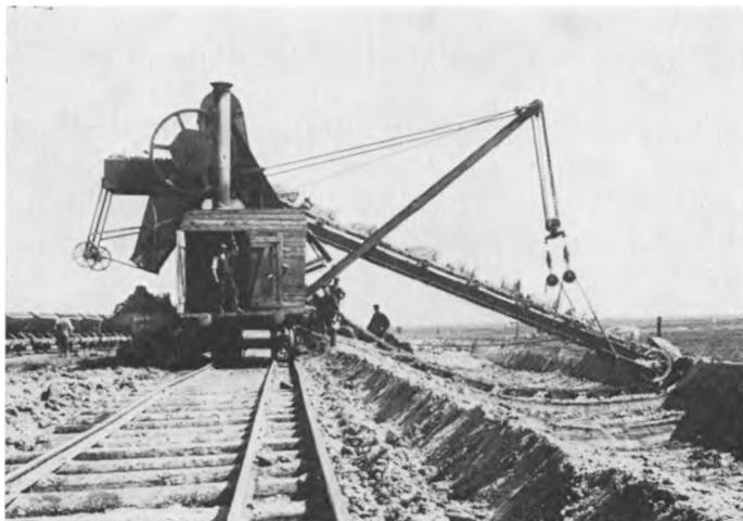
Fig. 7. Spandkædemaskinen, der udførte en stor del af gravearbejdet ved Ribe-diget. (Antikvarisk Samling, Ribe).
