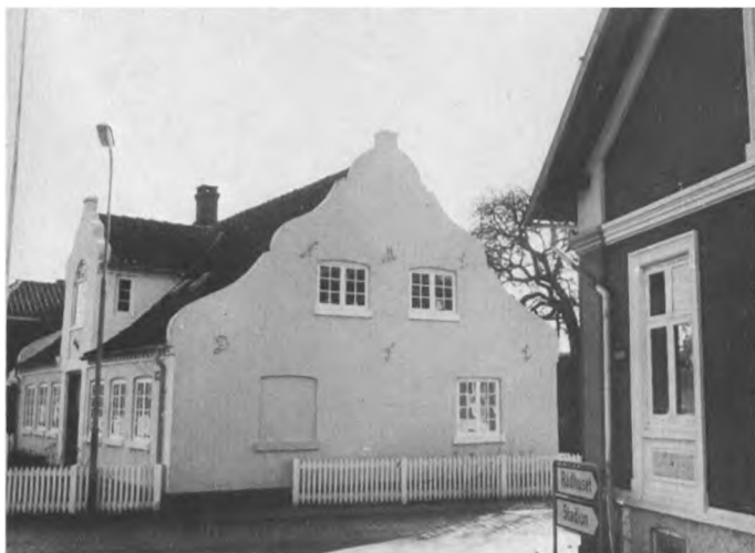
Svenskervej 12, bygget 1869. Fot. 1977 Esbjerg Museum.
