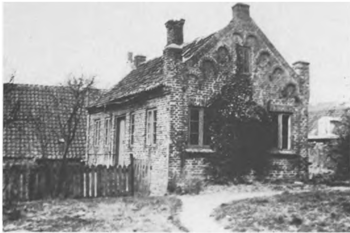
Huset, som herredsfoged C. P. T. Rosønørn lod opføre i 1853, havde fine murbuer i gavlene og fire hjørneskorstene, der iflg. bygningskommissionens forhandlingsprotokol udstyredes med såkaldte »russiske skorstenrør«. På et ældre fotografi ses i gavlen opslåede havedøre, hvorigennem der var adgang til den usædvanlig store have, der mod øst grænsede op til Arnbjerg.
