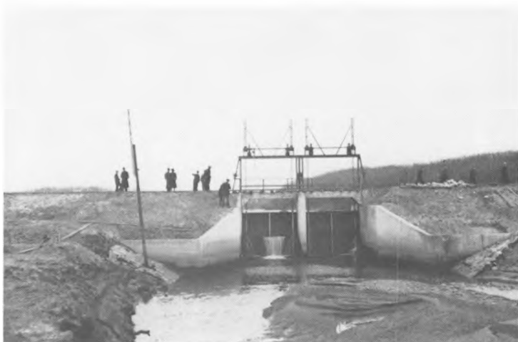
Fig. 10. Fra spærredæmningen med det lukkede stemmeværk ved det gamle åleje. Foto forf.
