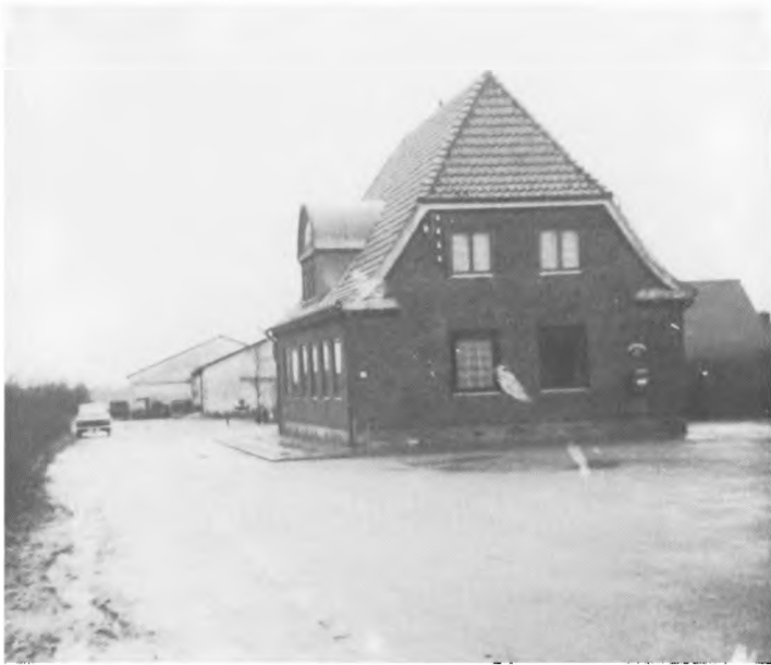
Fig. 10. »Vorbasse station« i dag; som det ses, er det ikke længere muligt at stige på toget. I følge de oprindelige planer skulle passagererne herfra have haft mulighed for at køre med tog til Holsted, Bindeballe, Grindsted og Kolding. Men Holsted-Bindeballe banen blev aldrig anlagt, og med udgangen af marts måned 1968 blev Trolldhede-Kolding-Vejen jernbanes strækning Trolldhede-Kolding nedlagt, efter at strækningen Gesten-Vejen var blevet nedlagt i 1951. Foto Lars Rasmussen.
