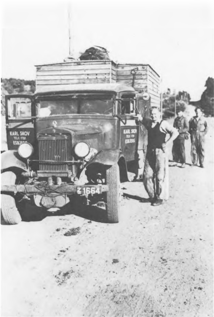
Fig. 15. Arbejderne fra Esbjerg blev transporteret til arbejdspladsen i skure på lastvogne. Mellem førerhus og lad skimtes gasgeneratoren. På taget ligger brænde i sække. Foto forf.
