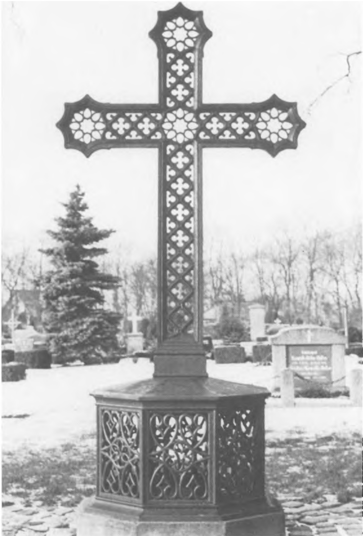
Fig. 2. Støbt gravkors på sokkel. Uden påskrift. Dette gravkors er antagelig unikt, men fremstillet efter samme metode som de øvrige. Monumentets enkelte dele er støbt hver for sig og derefter samlet. Ribe Kirkegård. Forf. fot. 1981.
