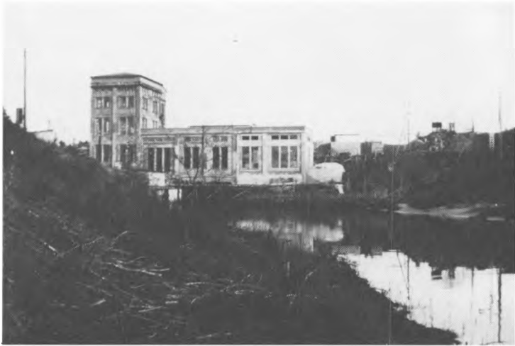
Fig. 5. Kraftværket efter tilbygningen. Til højre herfor ses turbinekammeret, og derover det ikke helt færdige forbindelsesrør, der fører vandet fra søen ned til turbinen. Foto forf.
