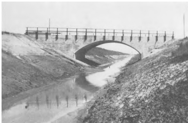
Fig. 11. En af de mange betonbroer der måtte anlægges i forbindelse med kanalarbejdet. Foto forf.
