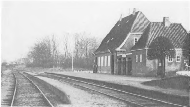
Fig. 5. Vorbasse station. Den 24/8 1917 foretoges den officielle indvielse af Troldhede-Kolding-Vejen jernbane, der passerede Vorbasse. I Vorbasse var det meningen, at Holsted-Bindeballe banen skulle have station fælles med Troldhede-Kolding-Vejen jernbane. Foto N. A. Johansen.
