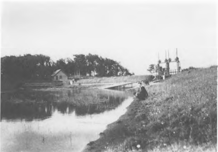
Fig. 8. Den færdige spærredæmning ved Ansager, til venstre stemmeværket til Varde å kanalen, og til højre stemmeværket til det gamle åleje. I forgrunden artiklens forfatter. foto forf.
