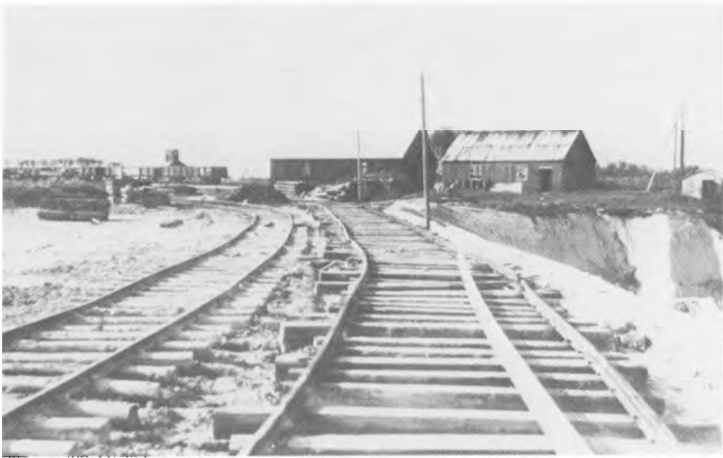
Fig. 10. Remise og smedie set fra gravemaskinen i 1935. Yderst til højre pumpehuset, der endnu i 1981 var i brug, dog som folkeskur i det sydlige hjørne af graven. Remisen er nyopført efter at være blæst omkuld i vinteren 1932-33. Bygningen anvendtes i 1981 som maskinhus. Godsvognene til venstre står på sporet ved lastbillæssepladsen.
