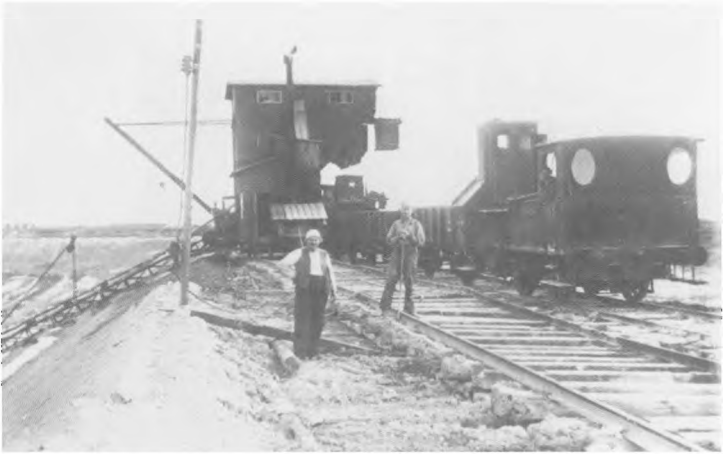
Fig. 6. Den store gravemaskine set fra nordvest en dag i 1935. El-kabel til maskinen udgår fra masten til venstre og ligger midt i sporet hen til en kabeltromle under et halvtag på dens nærmeste side, gravemaskinesporet og mergeltogsporet er netop blevet lirket endnu et stykke mod vest (til højre), så der er blevet plads til at grave sig endnu et stykke mod vest. Forrest står med hvid hat C. Silberbauer (driftsleder 1922-47), til højre Jens Lund og på lokomotivet Asmus Petersen. I baggrunden skimtes Heinrich Silberbauer i døren på venstre side af gravemaskinen.
