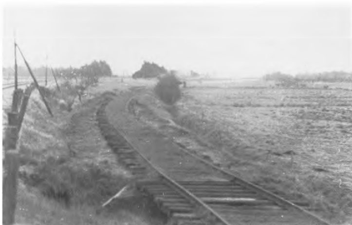
Fig. 5. Klåbygård-sporet umiddelbart nord for broen over Vester Vedsted Bæk, der skimtes allerforrest i billedet. November 1959. (S. A. Guldvang).
