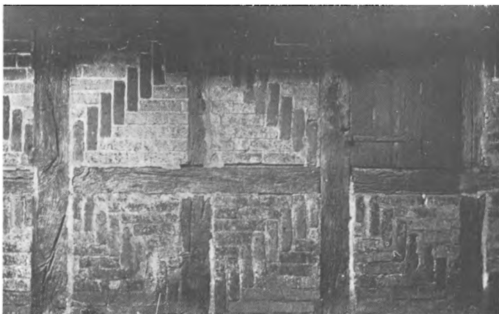
Fig. 17. Mur med bindingsværk og mursten i Janderup gamle præstegård. Nu nedbrudt. Efter fotografi på Varde museum.
