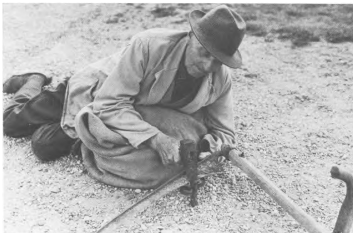
Fig. 14. Jakob Frandsen »hå'ere« (hærdet) en »jolle« (hø-le). Leens blad hviler på »æ hærspe« (ambolten), og Jakob slår på bladets æg med »æ hærdammer«. I enden af hammerskafstet er der et søm, som er stukket ind i den sæk med hø, som Jakob ligger på. Dette bevirker, at slagene hver gang rammer lebladets æg, efterhånden som bladet flyttes. Bemærk, at arbejdet foregår i liggende stilling. Foto: Knud Jensen 1973.
