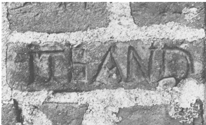
Fig. 11. Rød mursten fra gården matr. 7 Kærup, Janderup sogn. 22 cm lang og 6 cm høj. Inskription på en af stenens lange smalflader. Initialerne ITS og AND står for Jens Thøstesens og Ane Nielsdatter, der drev denne gård i første halvdel af 1800-tallet. Stenen er indmuret i den sydlige ydervæg i stuehuset, der skal være opført i grundmur i 1819. Bemærk det kantede S, der ligner de S'er, der findes på sten nr. III. Foto af forfatteren.
