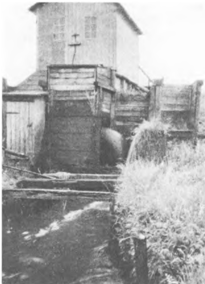
Glejbjerg elværks turbinhus fra før 1931, da der kun var en turbine på værket.
