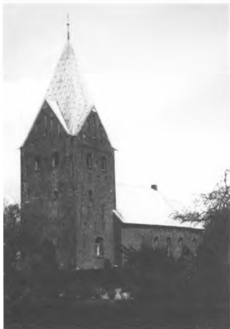
Seem kirke. Bemærk tårnet med de fire gavle, den såkaldte tårninglenske type. Foto: Jens Just, Esbjerg 1979.
