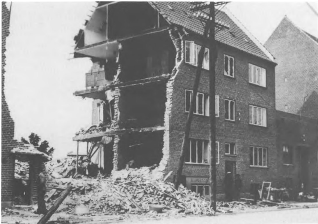
De ødelagte ejendomme i Frodesgade fotograferet et par dage senere, hvor det første oprydningsarbejde var overstået. (Byhistorisk Arkiv Esbjerg).
