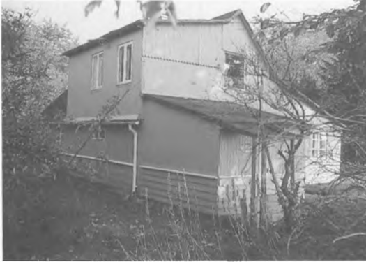
Huset set fra sydvest med den tilføjede taskekvist mod vest og tilbygningen mod syd. SMS fot. 1988
