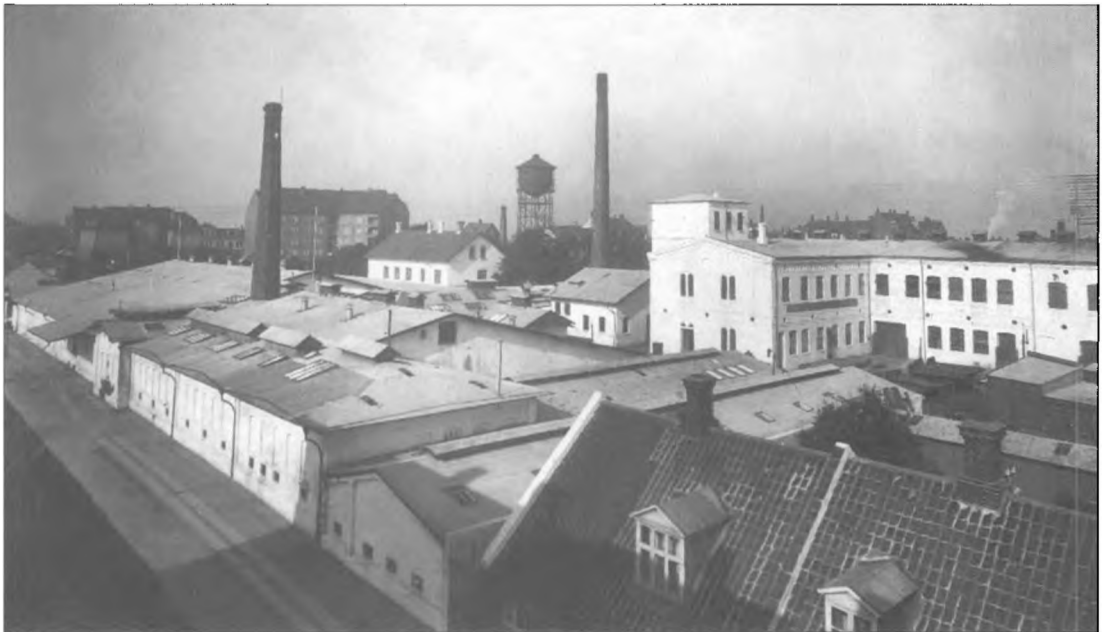
Andelsslakteriet i Nørregade. I 1920'erne med Kvindernes Hus og »Gryden« på Nygårdsvej i baggrunden.
