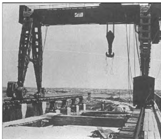
Fig. 6. Løbekran i »Tirpitzstillingen«. Løftekapacitet 175 tons.
