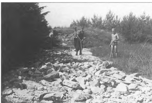
Betonvej brydes op.
