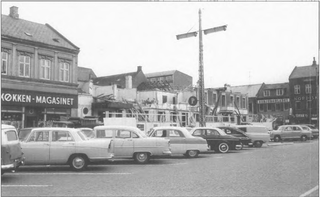
Nedrivning af Centralhotellet 1959. På grunden opførtes i 1960-1961 stormagasinet Central-Magasinet. Foto: Esbjerg Byhistoriske Arkiv. B. 3753.
