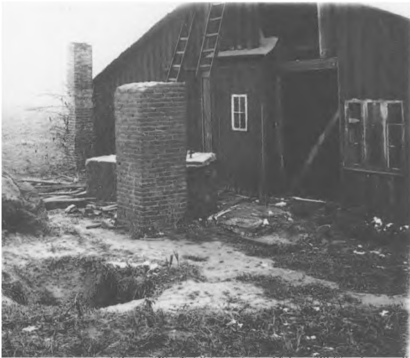
Foran Savmøllen ses resterne af den væltede mølle, bl.a. de murede piller, der bar udvekslingen, som overførte møllens kraft til en dynamo inde i huset. Savmøllen er for længst borte, men resterne af de murede piller står endnu.
