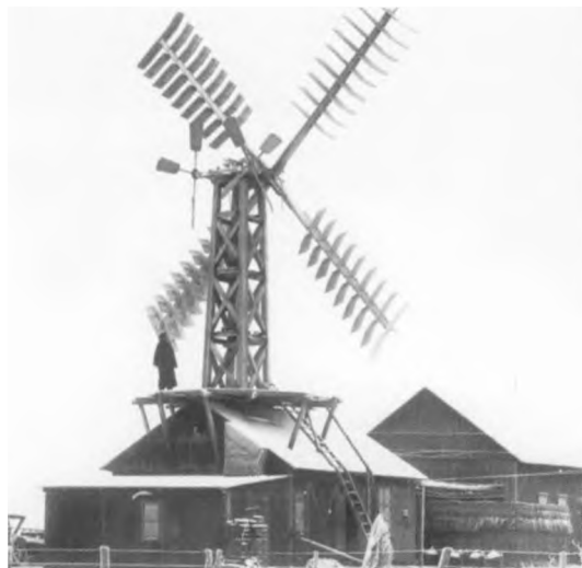
Den første forsøgsmølle fra 1891 set fra NØ. Under huset bag møllen var der beholdere til brint og ilt.
