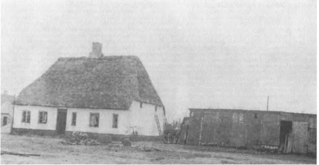
Huset der indtil 1884 var hovedskolen i Sønder Omme og som fra 1888-1936 blev anvendt som fattighus. Foto: privat eje.
