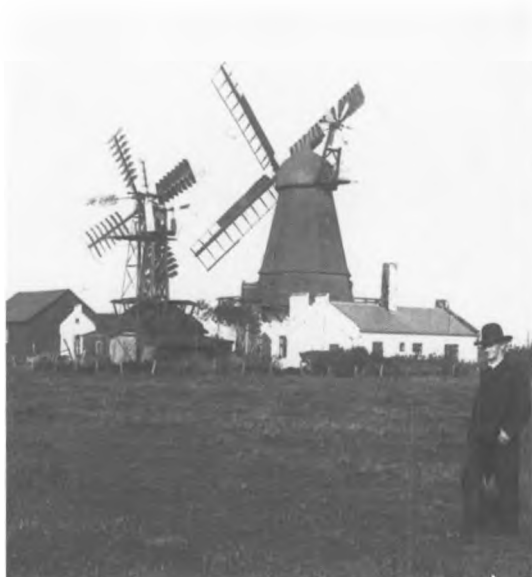
Poul la Cour på marken SØ for Forsøgsmøllen efter at det seksvingede keglevindfang var blevet afløst af et firevinget vindfang og efter opførelsen af den mellemste af de nuværende bygninger syd for møllepladsen før julen 1902.
