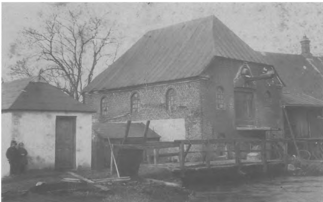
Lydum Mølle efter 1920. Den hvide bygning til venstre er sandsynligvis det nye turbinehus, som min onkel byggede omkring 1920, da han udvidede elproduktionen. Til højre for møllehuset ses et halvtag med en rampe i et lavere niveau end rampen til møllehuset; her er nok adgangen til mølleriet. De to børn, der står foran huset, kunne være min moster og onkels ældste børn, Ivan og Dagny.
