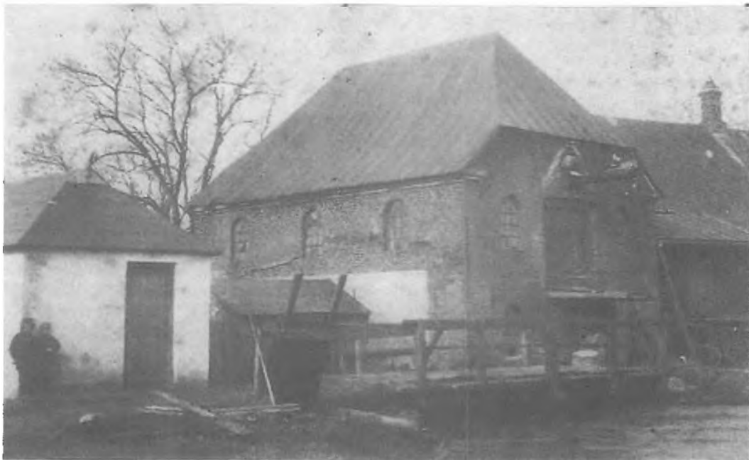
Lydum Mølle efter 1920. Den hvide bygning til venstre er sandsynligvis det nye turbinehus, som blev bygget omkring 1920, da elproduktionen blev udvidet. Til højre for møllehuset ses et halvtag med rampe i et lavere niveau end rampen til møllehuset; her er nok adgangen til mølleriet. De to børn, der står foran huset, kunne være Katrine og R.P.Jakobsen's ældste børn, Ivan og Dagny.
