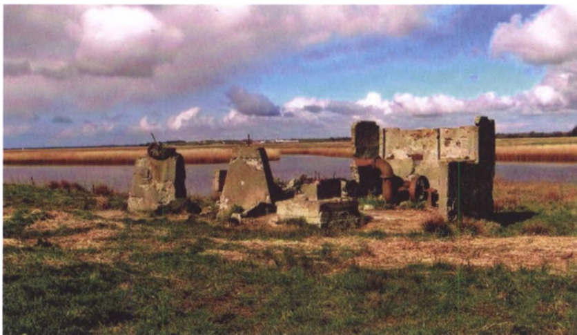
Rester efter pumpehus Visselbjerg enge (forfatteren 2011).
