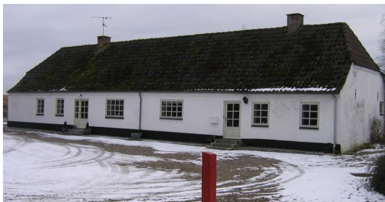
Stuehuset på Fjordvej 7 – februar 2009
