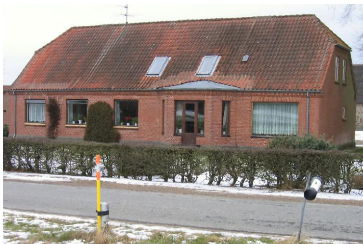
Billedet er taget fra Hvalpsundvej - bemærk kampestensmuren - bagest
