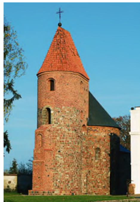
St. Prokop rundkirken, ibrugtaget marts 1133, med sit tårn i forgrunden. Kirken blev påbegyndt med tilhugne kvadre og afsluttet med teglsten. Samme metode blev brugt, da Bjernede rundkirke på Sjælland blev bygget (foto: wikipedia).
