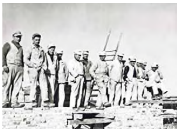
Bygningsarbejderne på stilladserne ved grundstensnedlæggelsen.
